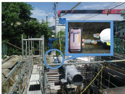
デジタル技術を導入した継手管理の様子
